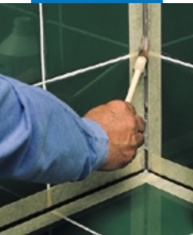
Application of Primer FD
